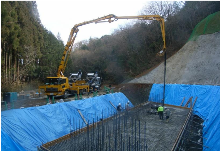
フーチング 生コンクリート打設
