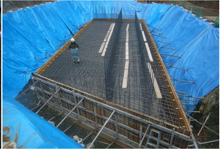
フーチング配筋・型枠
