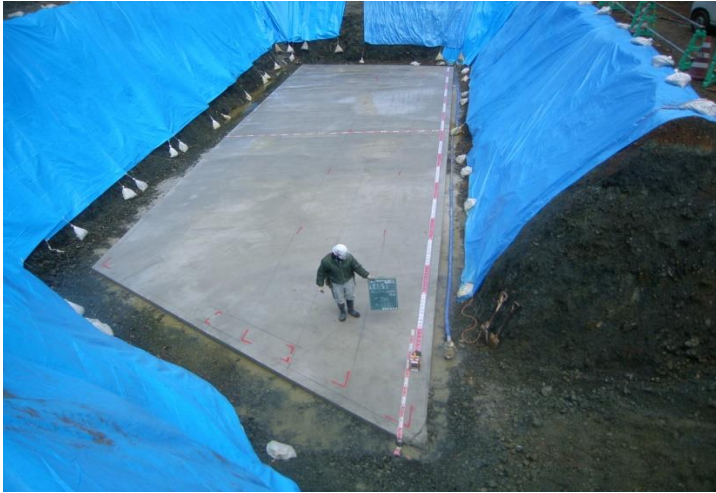
均しコンクリート出来形
