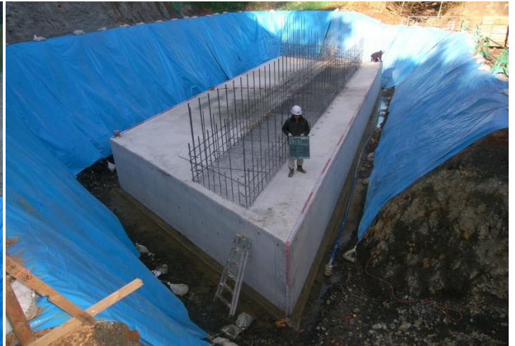
フーチング 出来形
