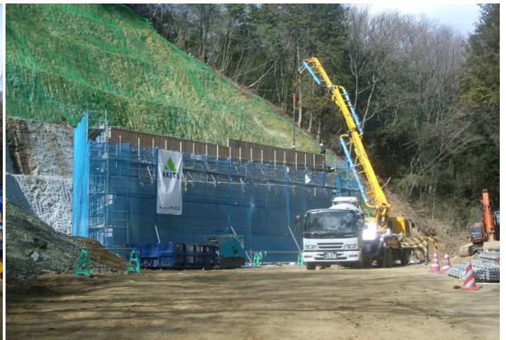
橋台 生コンクリート打設
