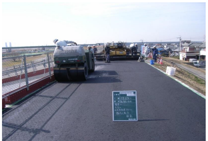
堤防天端舗装工事
